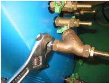
写真の様にスパナなどで、ストレーナの付根のニップルを緩め、ストレーナ本体を給水口から外してください。
